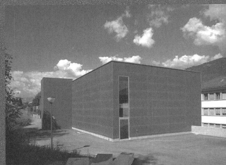
Architektur Dayer + Venetz, Sion Foto: Croci + du Fresne, Worblaufen
