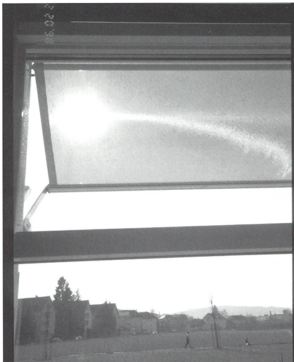
Abb. 8: Gitterstoffstoren eignen sich nicht als Blendschutz gegen die Sonne.
