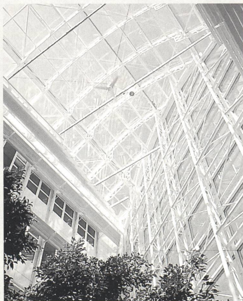
Betriebsgebäude EWZ, Zürich
