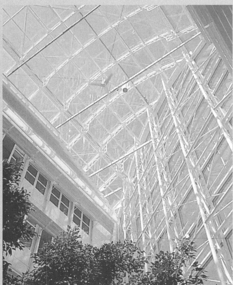
Betriebsgebäude EWZ, Zürich
