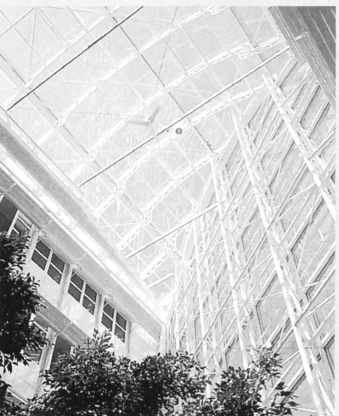
Betriebsgebäude EWZ, Zürich
