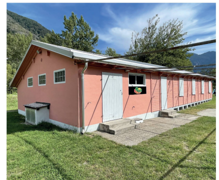
Il neo ristrutturato capannone polivalente di Golino (foto: Andrea Fenaroli)
