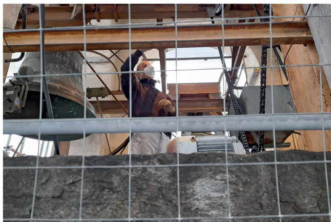
Tinteggiatura del meccanismo delle campane
