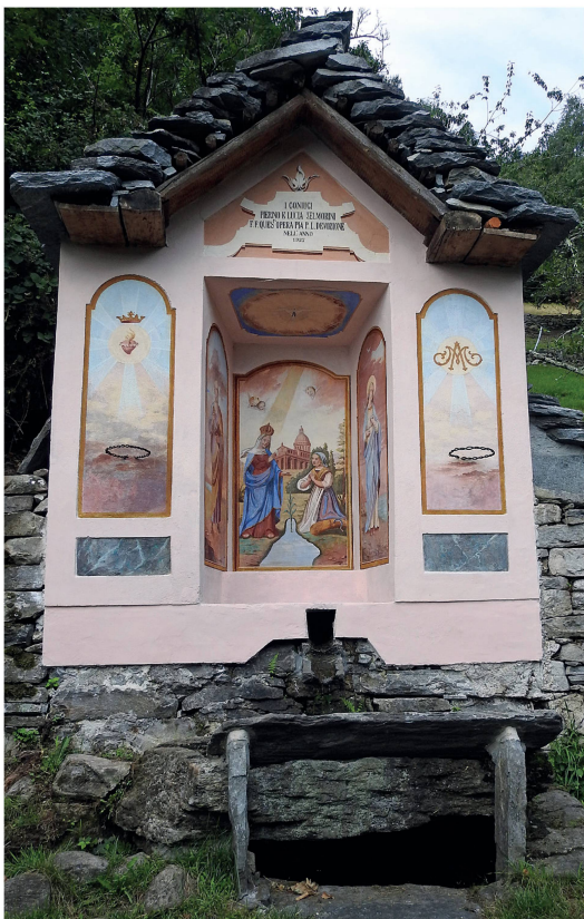
Cappella e fontana dopo i lavori di restauro, vista frontale. Foto Fausto Beretta
