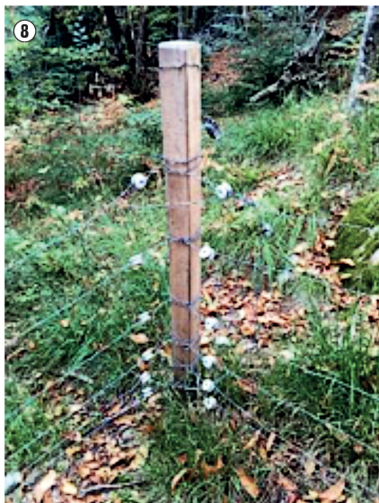
Foto 8: dettaglio di un angolo della possente recinzione elettrificata anti cinghiali e anche anti lupo!
