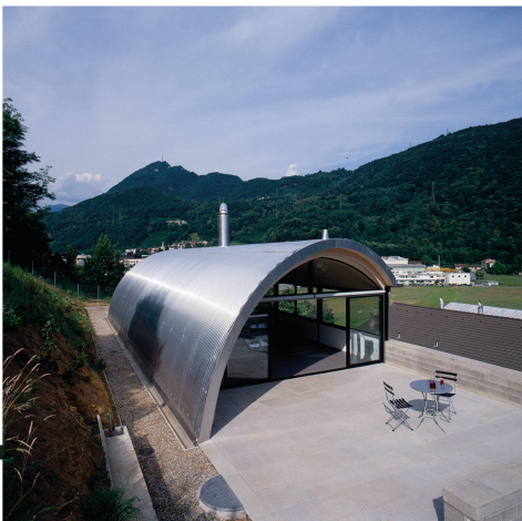
Casa a Montagnola 1995 La lama curva della copertura di alluminio che emerge dal terrazzo
