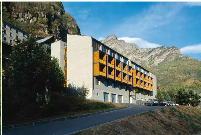
Centro sociale Valle Onsernone 1988 Riproposta delle tipiche "lobbie" onsernesi per gli alloggi degli anziani
