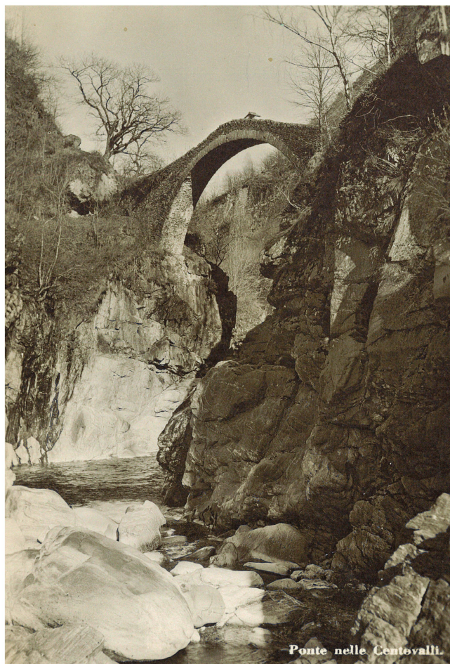
Foto d'epoca del Ponte Romano, costruito nel 1578 a 26 metri di altezza sopra la Melezza. Sopra l'arco del ponte s'intravedono le falde del tetto della cappella.
