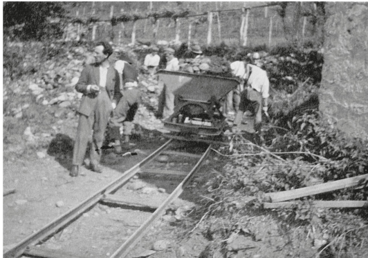
Lavori a Verscio.
