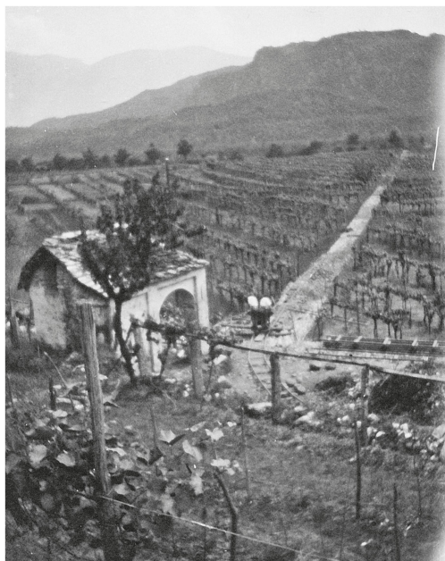
Lavori a Verscio.
