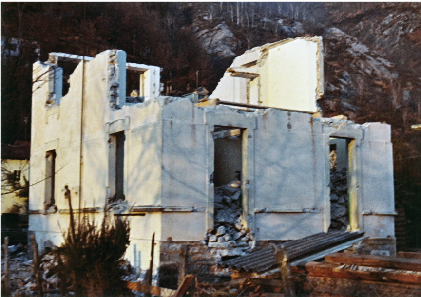
Demolizione del vecchio Asilo per far spazio al nuovo edificio. (Foto Renato Managlia)
