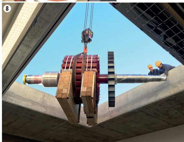
Il rotore del generatore. (foto 8)
