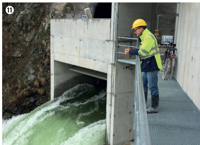
richiudere ogni singola pioda. All'11 aprile la galleria rientra in servizio con l'acqua che per la prima volta esce dallo scarico di emergenza della centrale. (foto 11)
