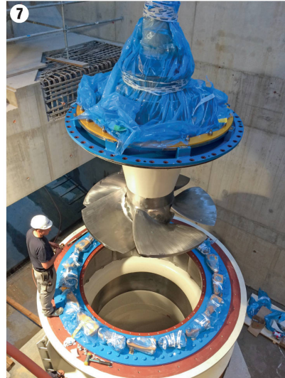
La bella girante Kaplan con 5 pale regolabili (foto 7)
