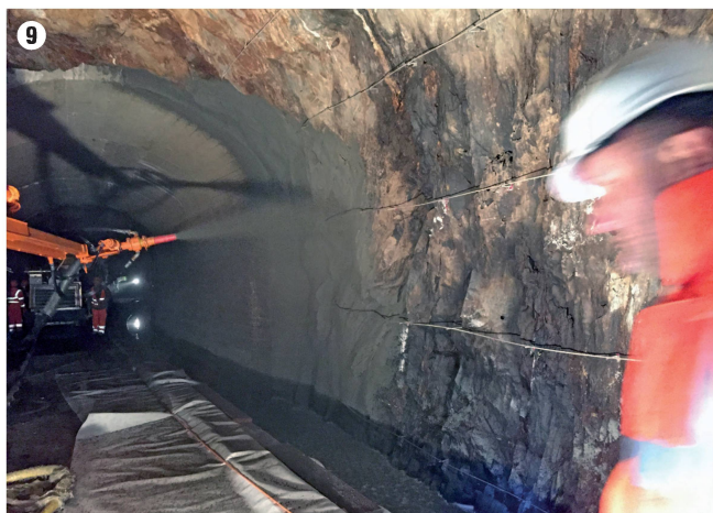
balzo, manutenzione dei macchinari e riposizionamento del cantiere mobile. (foto 9)
