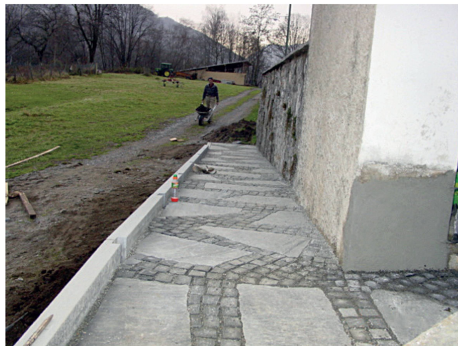
Rampa eseguita nel 2009
