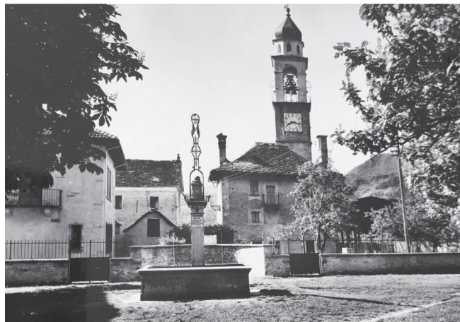
La fontana "moderna" in cemento della piazza. Ora demolita.
