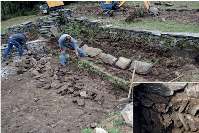
Durante i lavori
