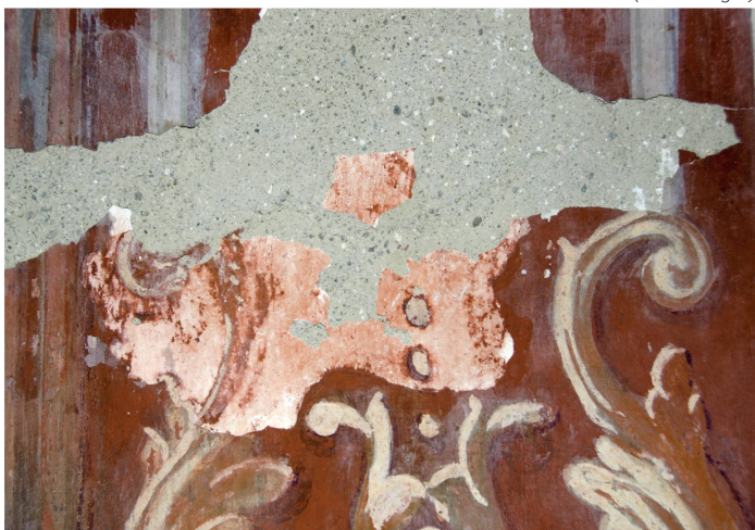
Deterioramento intonaco con affreschi (Foto G. Cugini)
