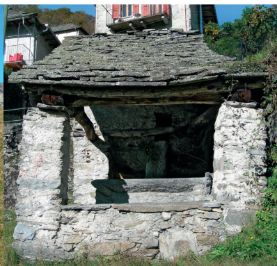
Lavatoio a Pila
