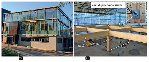
Fig. 2: ETH House of Natural Resources: (a) vista esterna dell'edificio; (b) il telaio precompresso di abete e frassino costituisce lo scheletro della costruzione
