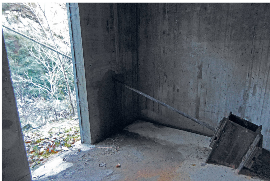
Nelle foto il sistema d'attacco del filo portante.
