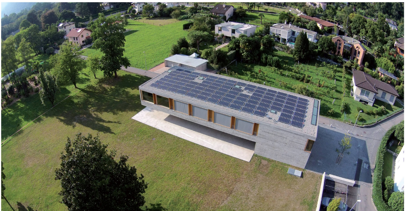
Immagine dell'impianto fotovoltaico "Minergie A" effettuata con un drone da Roberto Di Bacco.
