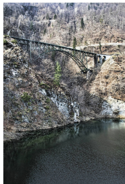
Ponte dei Ruinacci sopra il Lago di Palagnedra.
