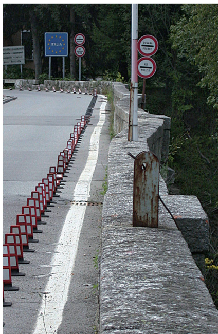
L'evidente degrado del vecchio parapetto.
