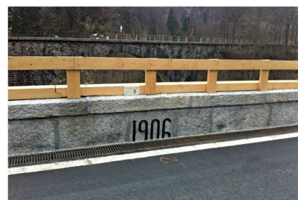
Evidente in questa immagine la data di costruzione del ponte, in parte sommersa dal fondo stradale. (foto Alma Pedretti)
