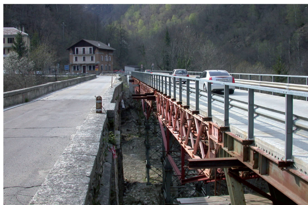
Il ponte provvisorio, ora smantellato, che ha garantito il traffico veicolare durante i lavori sul vecchio manufatto.
