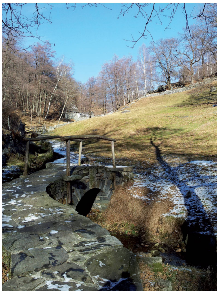
Ponte, muri a secco e selciato ripristinati tra Riei e Streccia. Anni 2002-2010.
