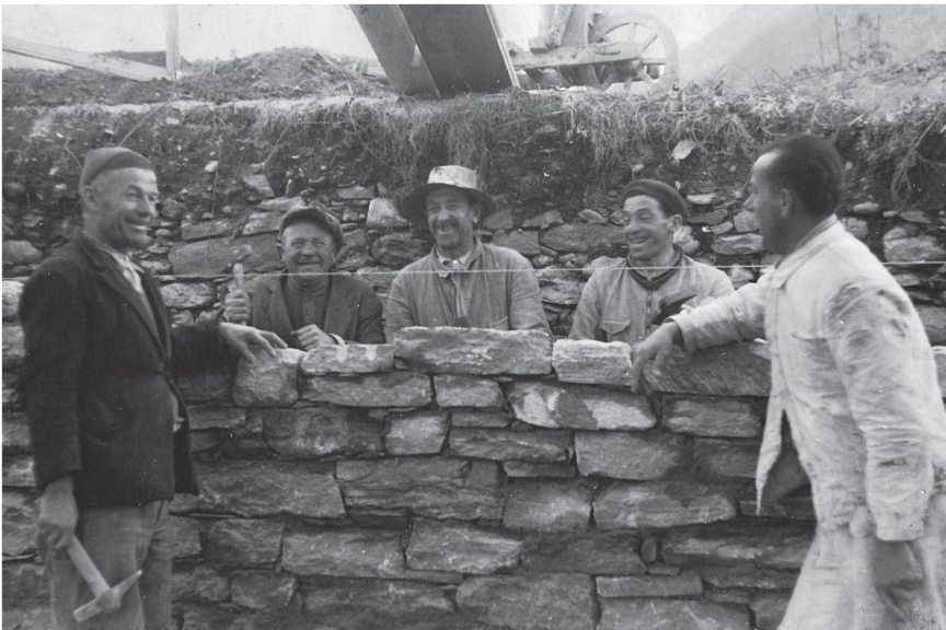
In un cantiere ad Ascona nel 1942. Il Faustin a sinistra con i compagni di lavoro Sala, Biscara, Fabbri e Riva.
