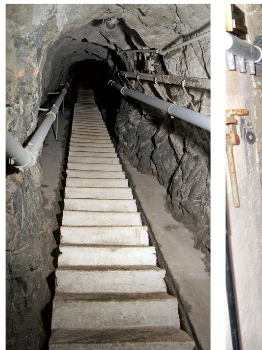
Scala di accesso alle camere di combattimento
