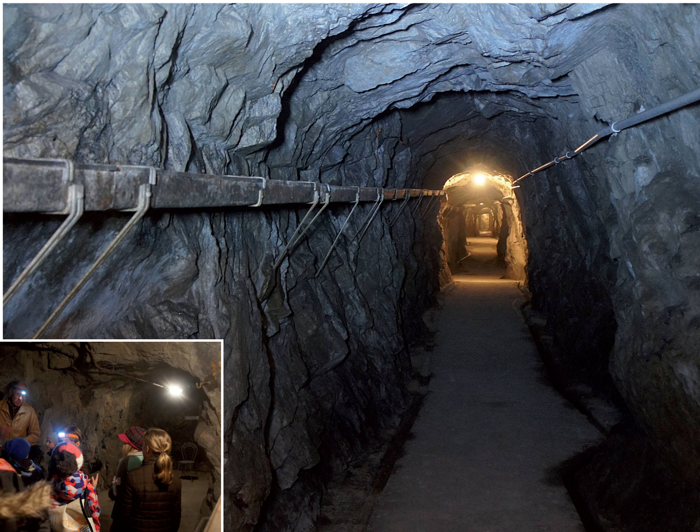
Lungo il cunicolo di collegamento fra Tegna e i Grotti
