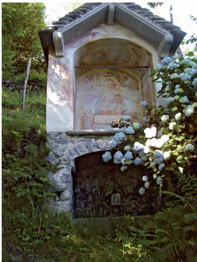
La cappella prima e dopo il restauro
