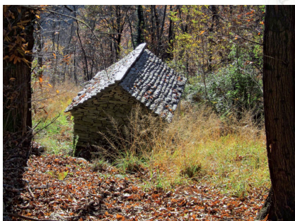
Fronte e retro della "Capèla du Per"
