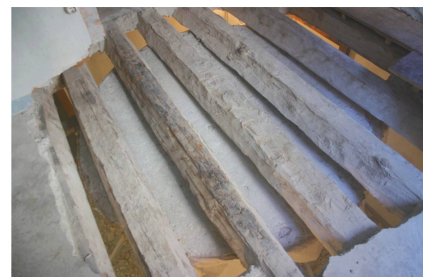
5- Demolizione della soletta dal sopra.
