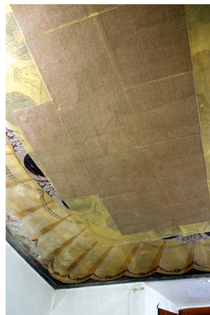
3- Preparazione del pannello e del cuscinetto ammortizzatore per la posa dell'intonaco da staccare.
