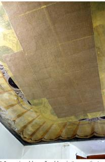
**3**- Preparazione del pannello e del cuscinetto ammortizzatore per la posa dell'intonaco da staccare.
