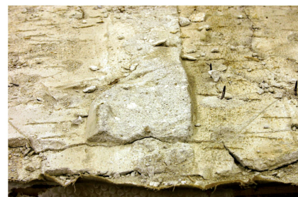
7- Sul retro dell'intonaco sono presenti alcuni chiodi. La testa dei chiodi, sul davanti, si trova troppo vicino all'intonachino dipinto. Vengono perciò tolti in laboratorio e ultimato anche l'assottigliamento dell'arriccio fino all'intonachino dipinto.
