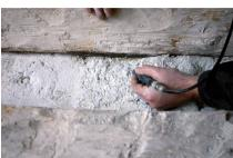
6- Completa demolizione della malta mediante microablatori. le travi della soletta sono distanziate tra loro a cm 20 e sono svasate per accogliere il riempimento in assi posizionati a coltello.Sotto il legno, per migliorare l'ancoraggio della malta, è presente una ramificazione di chiodi e filo di ferro.
