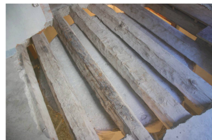
5- Demolizione della soletta dal sopra.
