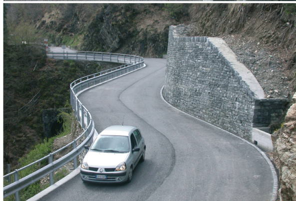
Gli allargamenti in prossimità del paese di Camedo
