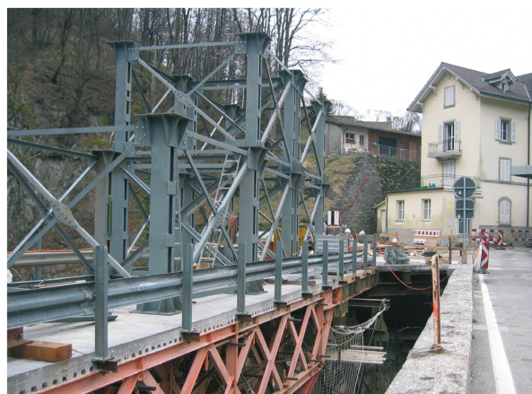
I lavori per il ponte provvisorio sul fiume Ribellasca. (foto pte)
