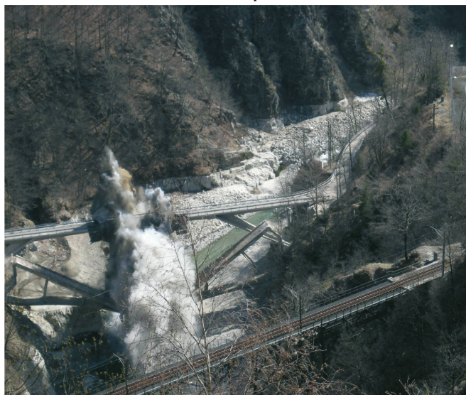
26 marzo 2008, l'ultimo atto del vecchio ponte
