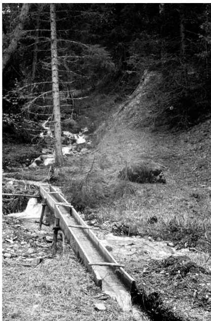
Una "Bisse", condotta per deviare l'acqua di un ruscello ai campi coltivati
