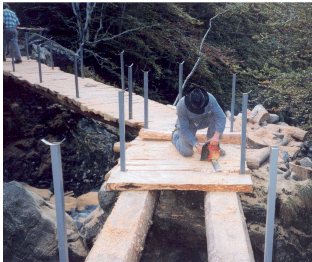
Costruzione del ponte in Val di Bordei.
