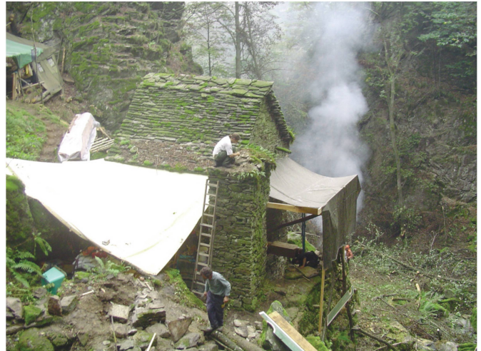
Flavio Poletti, con un giovane, è impegnato nella ricostruzione dei muri a secco con sassi recuperati e lavorati sul posto.
