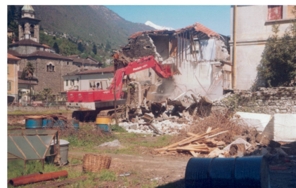
...e la sua demolizione. (foto archivio A. Losa)
