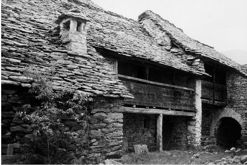
Cavigliano, nucleo del paese: antiche case dei Peri, prima della ristrutturazione.
