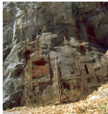
In copertina: Entrata mimetizzata del fortino dietro all'ex Grotto Michelangelo, fotografia di Axel Fuog.
