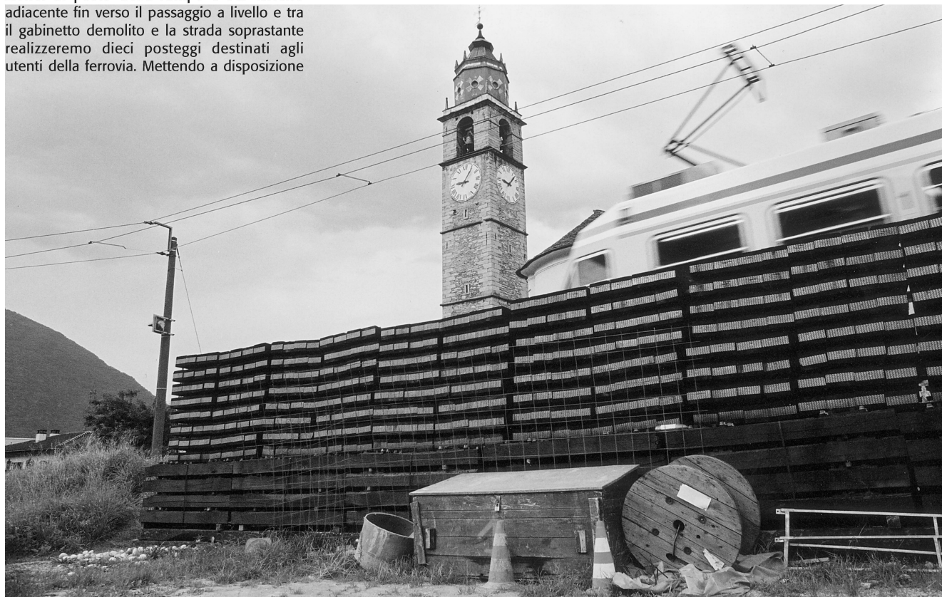
Verscio, inizio novembre 2001. Sedime a nord del cimitero. Traversine in attesa della posa.
