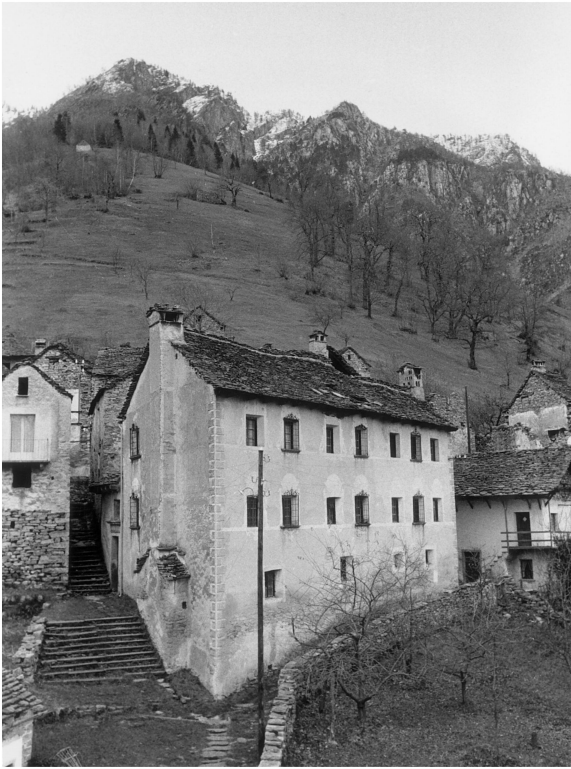
Per il "Palazzo Tondù" di Lionza ci sono buone premesse per una sua ristrutturazione attraverso il progetto Centovalli; la prima fase consentirà di allestire uno studio di destinazione e fattibilità accompagnato da un progetto di massima.
