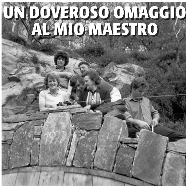
Sull'arco del ponte in costruzione: da sinistra a destra Monica Zanda, Eros Verdi, Aldo Ceroni, Diego Pellanda, Lina Bonetti e Chino Zanda (1977).
