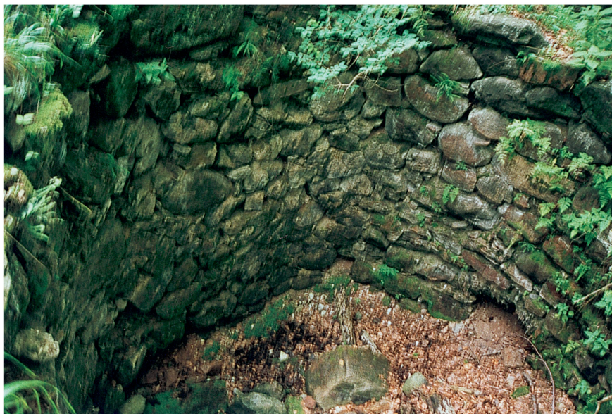
L'interno della fornace che è attualmente in fase di restauro.
