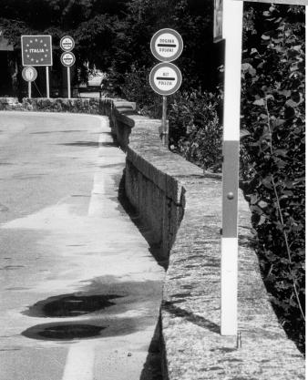
Il ponte sulla Ribellasca, al confine italo-svizzero è stato recentemente consolidato; contatti sono in corso con l'autorità italiana per provvedere ad un suo allargamento mediante la posa di elementi prefabbricati e la sostituzione dei parapetti divenuti pericolanti
