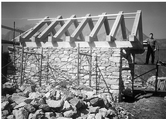
Durante i lavori
