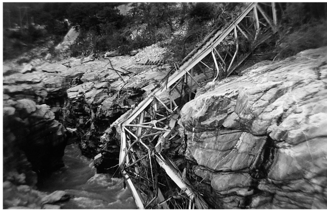
8 agosto 1951 distruzione del ponte in ferro di Ponte Brolla
