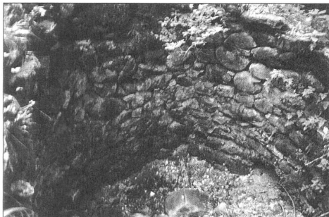
Fornace per la calce
