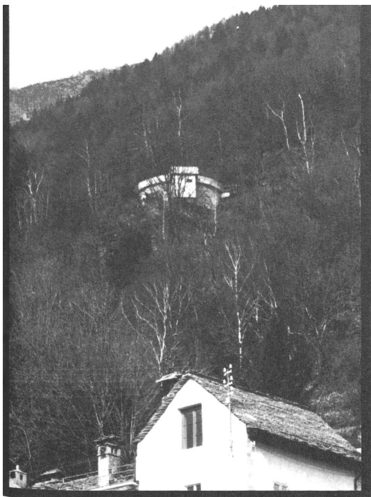
Serbatoio polmone con misura di livello
