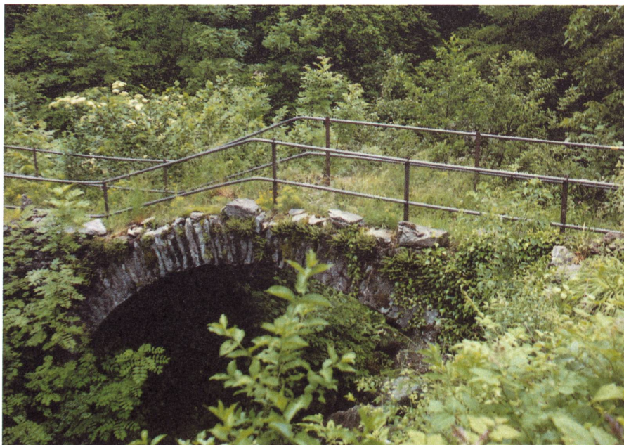
Il ponte in zona Remigliasco prima del restauro...
