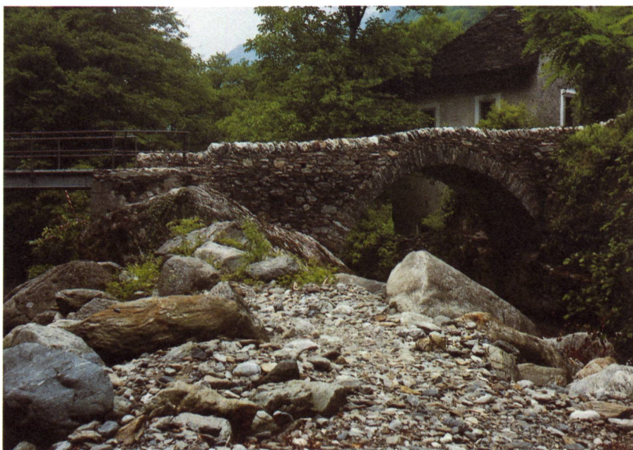
... e dopo il restauro
