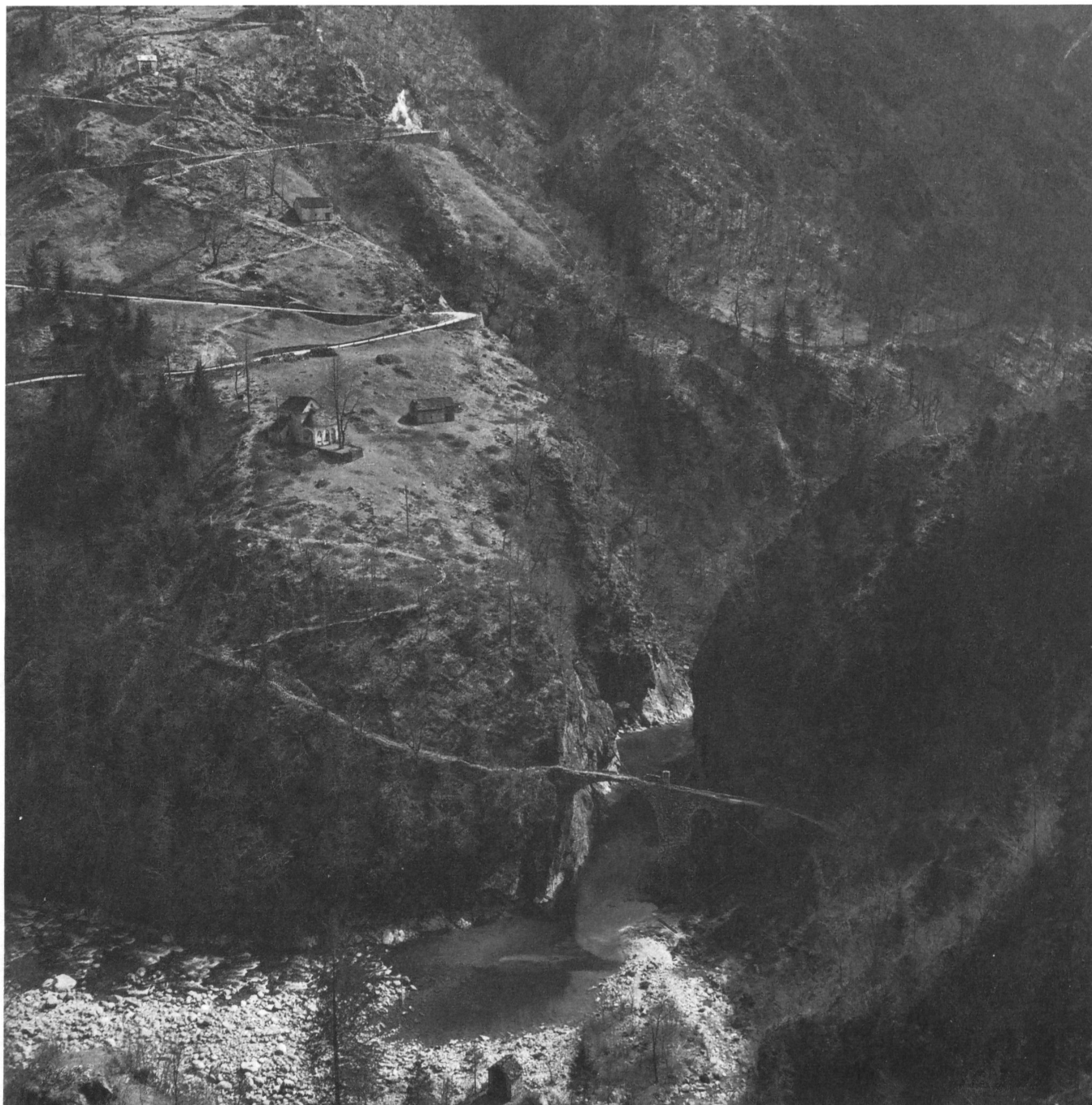
Prima dell'attuale raccordo costruito alla fine del secolo scorso, il sentiero per Palagnedra, dopo un lungo giro poco sopra il fiume, passava su questo ponte, detto il vecchio ponte dei Sirti e sommerso nel '53 dal bacino di accumulazione.
