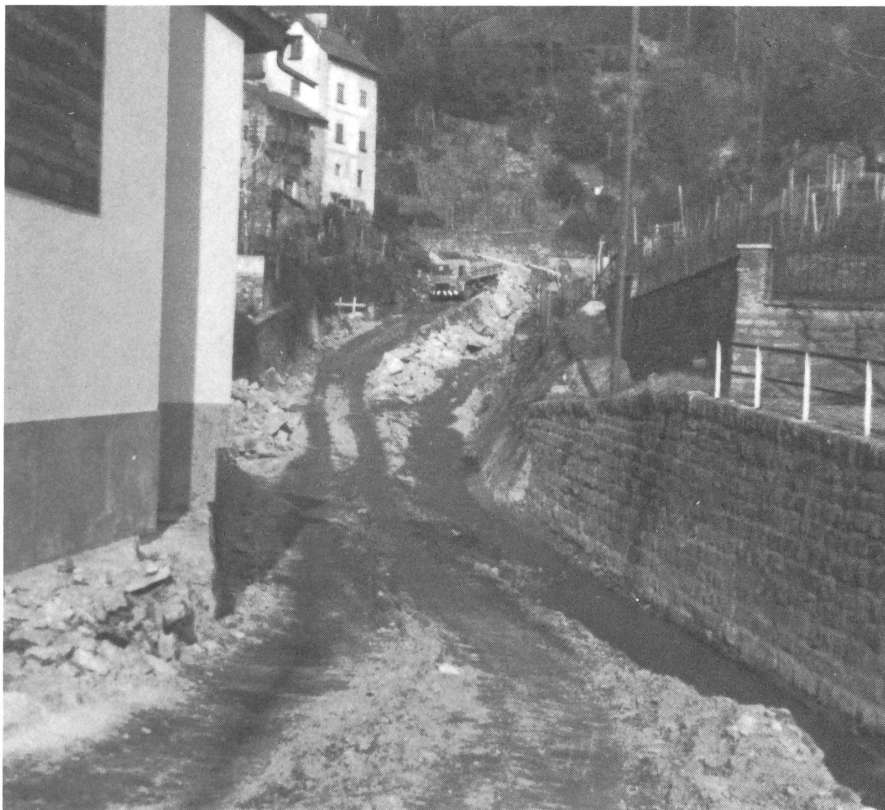
Lavori di sistemazione del riale di Riei dopo l'alluvione del 1977.
