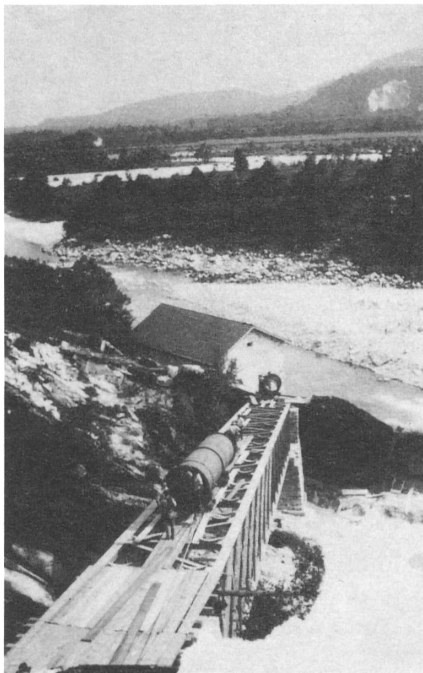
La costruzione della centrale idroelettrica, nel 1904.
