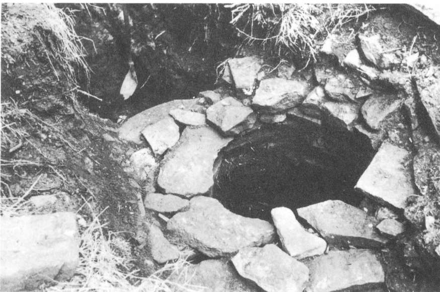
Il pozzo prima del restauro (foto A. Gerster)
