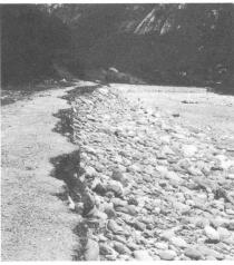
L'argine provvisorio — formato con il materiale estratto dall'alveo del fiume — in territorio di Verscio è stato in parte asportato, mettendo a nudo l'inizio delle arginature, che sono ora in pericolo
