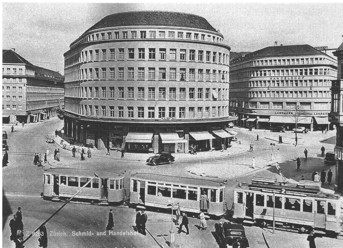
Abb. 3: Zürich, neue Sihlporte um 1930. Die Architektur des Platzes und der umgebenden Bauten feiert den modernen Verkehr, dessen Bewegung sich im Schwung der Fassaden fortsetzt. (Baugeschichtliches Archiv der Stadt Zürich)
