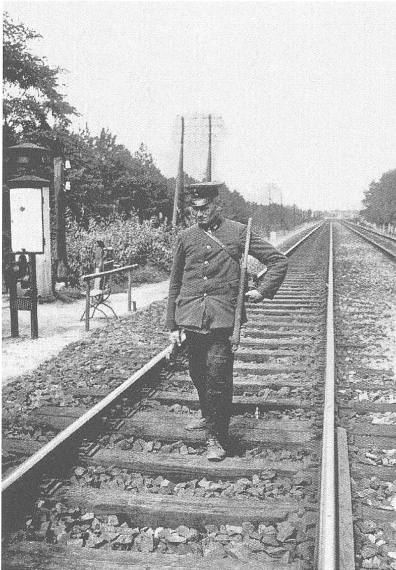
Abb. 1: Historische Aufnahme eines Streckenläufers der Deutschen Reichsbahn aus dem Jahr 1934. In der rechten Hand trägt er einen Schraubenschlüssel zum Festziehen von Schwellenschrauben; zur Linken sind Signalflagge und Knallkapseln umgehängt, die er benötigt, um im Notfall Zügen Haltesignale zu erteilen. («Der Streckenläufer», Foto: Bildarchiv des Reichsverkehrsministeriums, Eisenbahnstiftung Joachim Schmidt, Bild ID: 56865)
