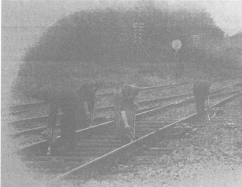
Abb. 6: Werbefoto mit Arbeiter:innen für eine der frühen Gleisstopfmaschinen, die die schwere körperliche Belastung dieses Arbeitsschrittes vereinfachen und damit den Einsatz von Frauen und älteren Männern in Zeiten des Arbeitsmangels ermöglichen sollten. (Anonymus, «Besichtigung der Gleisstopfmaschine bei der Bahnmeisterei 33a durch die Abteilung Berlin am 11. November 1916», WfdBm 33 [1916], 963–965, hier 965)
