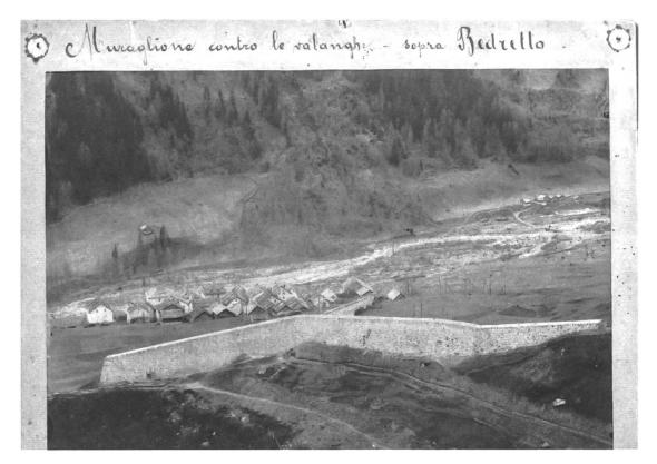
Fig. 3: Mur de protection au-dessus du village de Bedretto (Tessin). Source: Ufficio forestale 1º circondario, Faido, classificatore, Foto vecchie (valanghe).
