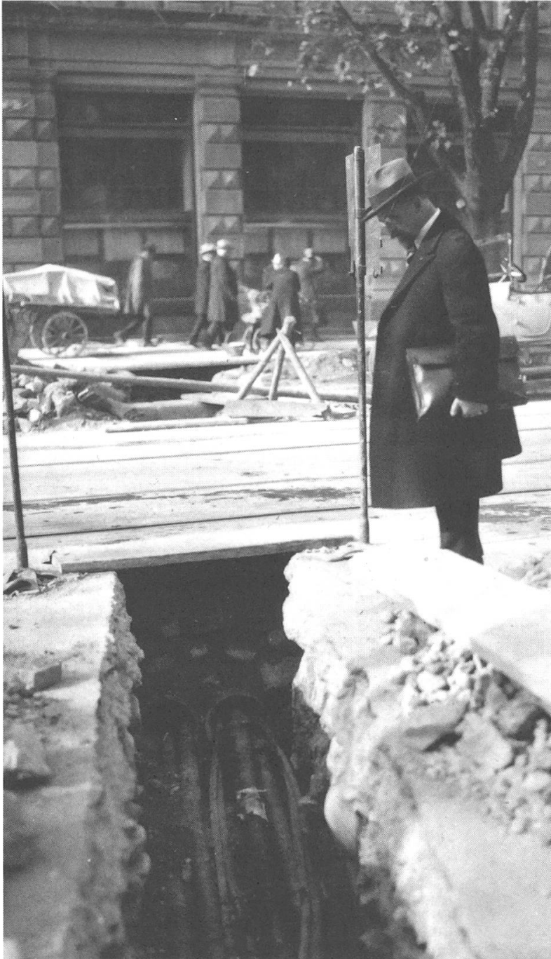
Abb. 1: «Stadtrohrpost Zürich. Rohrverlegung an der Ecke Kappeler-gasse/Bahnhofstrasse», 1925. (PTT-Archiv, Tele-012 A 003_5, Photos von Rohrpost- und Förderbandanlagen, Zürich)
